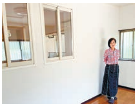
隣のダイニングキッチンとの仕切りの壁(左)は一部くり抜いて白枠の小窓を新設。光が入り開放的にしました。
